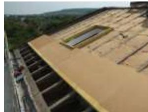
Exemple d'isolation sous (sarking) et sur toiture
