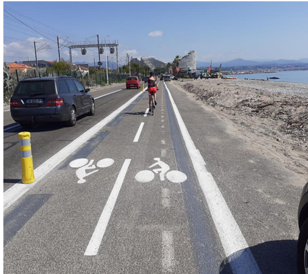
Piste bidirectionnelle sur chaussée réalisée par le Dpt 06, mise en service juin 2020, Antibes, @dpt06
