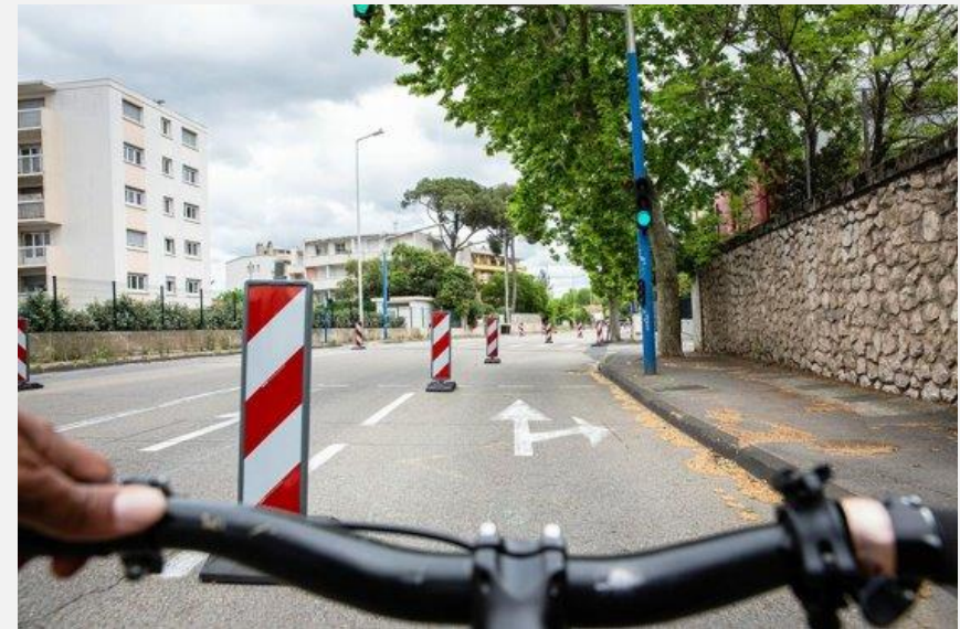
Piste cyclable à Montpellier (neutralisation d'une voie auto via balises) mise en service en avril, @David Richard
